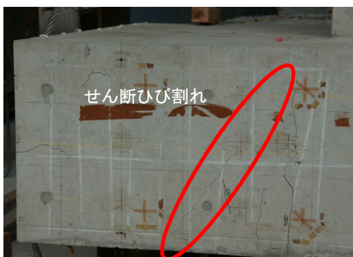
(b) 東側側面に発生したせん断ひび割れ
