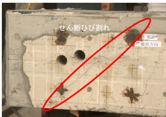
(b) 東側側面に発生したせん断ひび割れ
