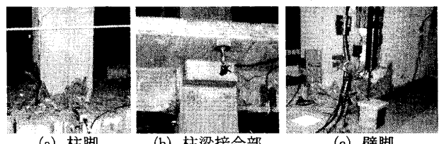
図11 損傷状況 (JMA Kobe 100%入力加振後)
