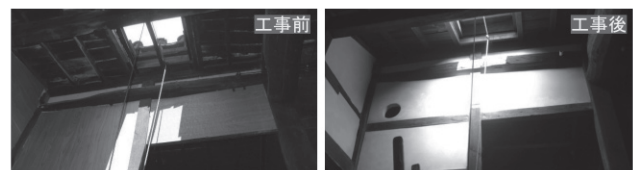
写真3 修理・修景工事とあわせて行われた建築物内部の改修例 地図対応番号-14 (写真左：改修前、写真右：改修後)
