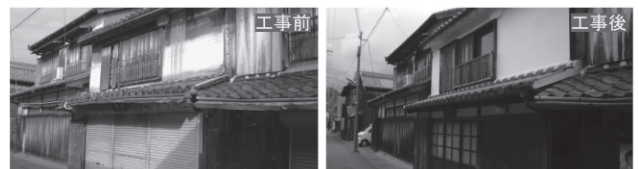
写真2 重伝建地区選定以前の修理・修景工事の実例 (中央) 地図対応番号-5 (写真左：改修前、写真右：改修後)
