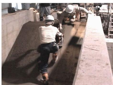
上流法面仕上げ面締固め
