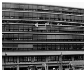
中層階が潰れた神戸市役所
