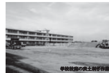
学校敷地の夜土留め作業
