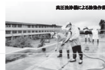
高圧洗浄機による除染作業
