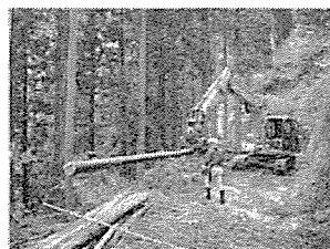
伐採・搬出作業
