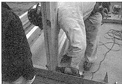
写真-4: ユニット建方ボルト締め作業 Photo-4: Bolting work for units' assembly
