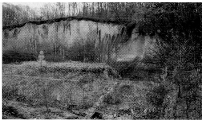
オカバルシ川「小鳥の村」（札幌市）における施工例
