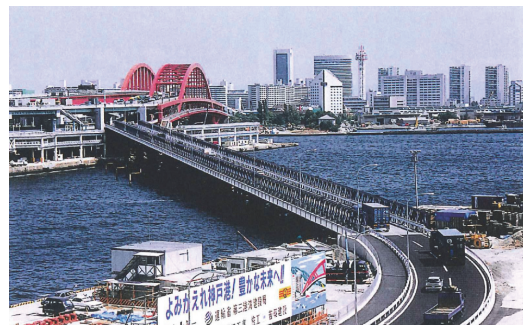
写真1.2 代替道路（仮橋）の設置状況
