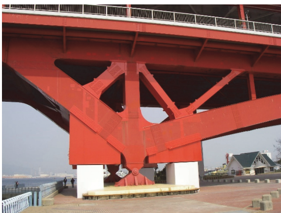
写真 4.1 中間支承の段差防止構造例
