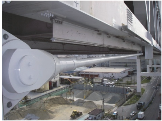
写真 3.1 橋軸方向変位制御装置例
