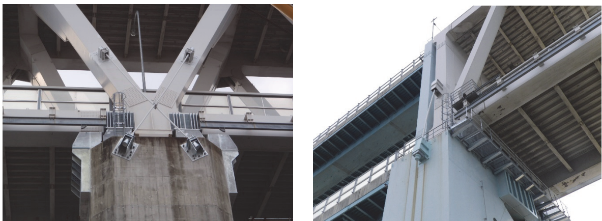
写真 5.1 上路式鋼トラス橋の上揚力対策
