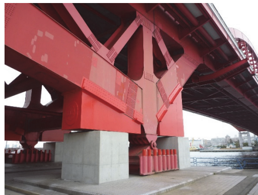
写真 4.3 アーチリブ当て板補強例
