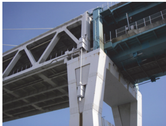
写真 3.2 端橋脚アップリフト防止構造案例
