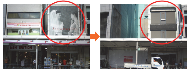
写真-3 固定型屋外広告物の撤去
