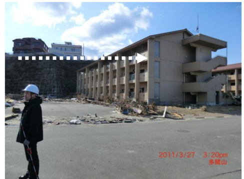
(2) 町営マンションの被害状況 (K10)
