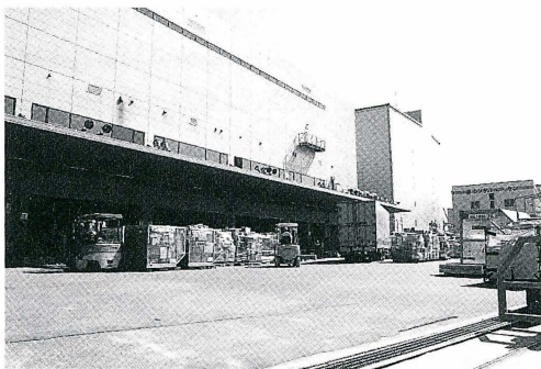
写真4 液状化被害が軽微な事業所（新木場）
