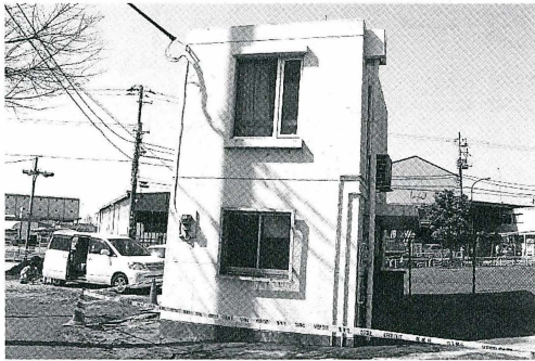
写真3 沈下・傾斜した交番（新木場）
