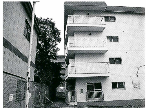
写真6 大崎市古川中里のアパートの傾斜（撮影日：2011/4/7）
