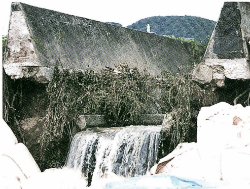
図22 河川堤の破断面（8月15日）
