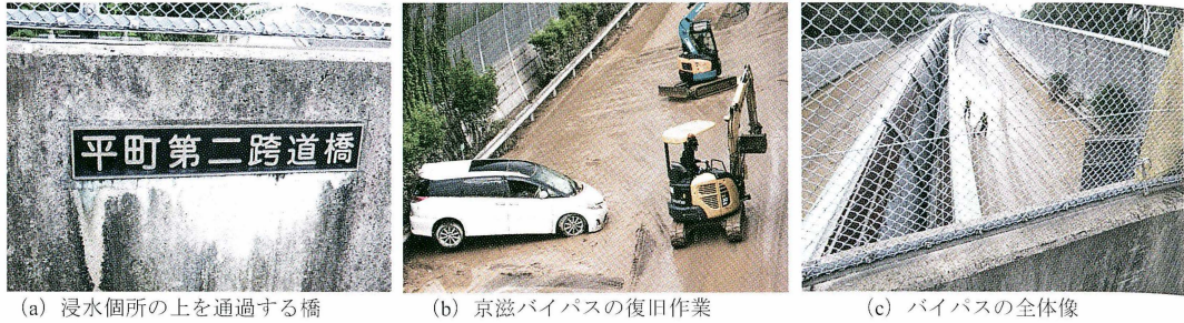
図15 京滋バイパスの復旧作業の状況（8月14日15：00）
