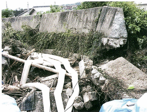
図23 ポンプによる排水（8月15日）
