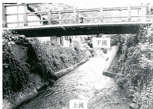
(a) 被災前の前川橋
