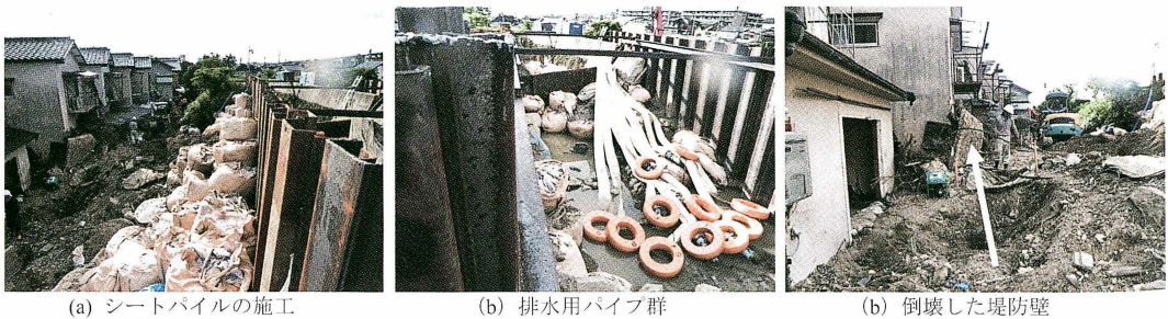
(a) シートパイルの施工
