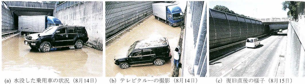
図16 バイパスに並行した府道での被害（8月14-15日）
