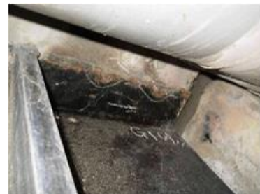
図4-15 腐食の発生状況
