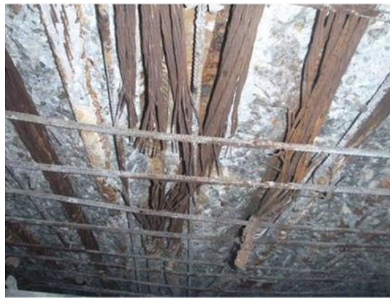
PCケーブルの破断
