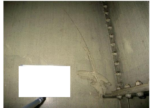
図 4-3 発見時の疲労き裂
