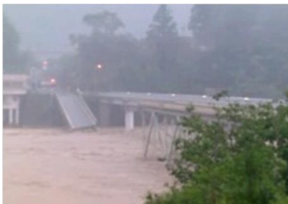
図 1-11 台風 12 号で流出した折立橋 (国道 168 号 奈良県十津川村)
