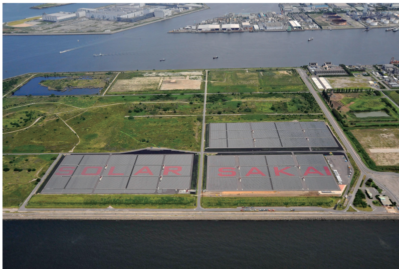
〔図1〕堺太陽光発電所の全景
