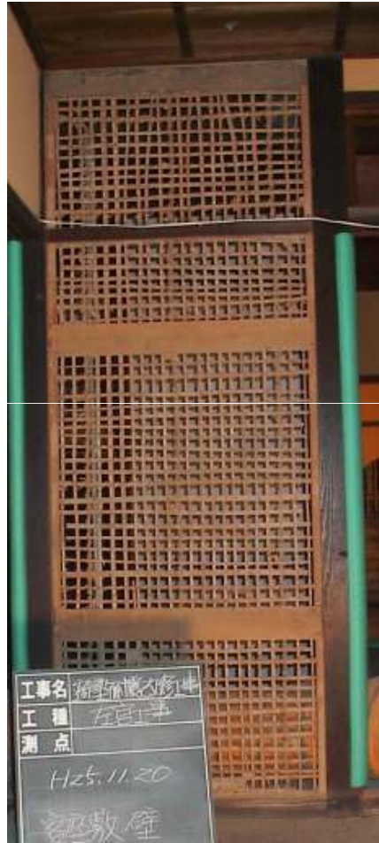
↑既存壁の解体状況 小舞竹下地
