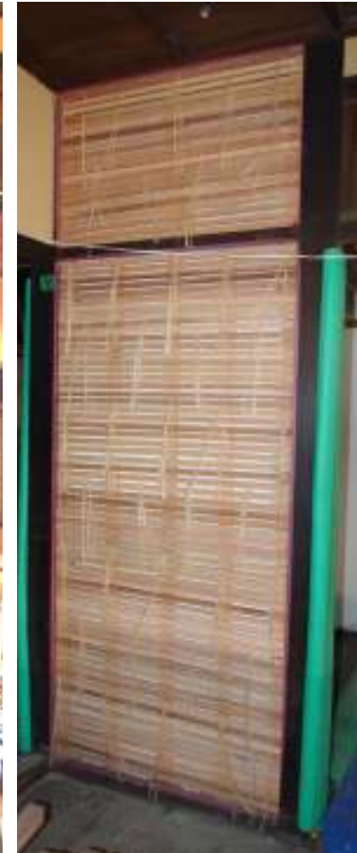
↑新設壁下地の設置状況 木摺下地
