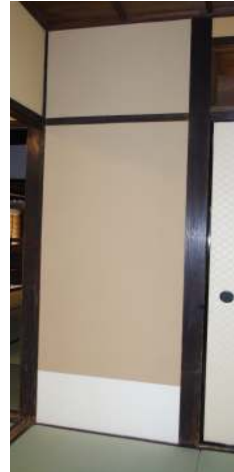
↑土塗壁復旧状況 聚楽塗り仕上げ
