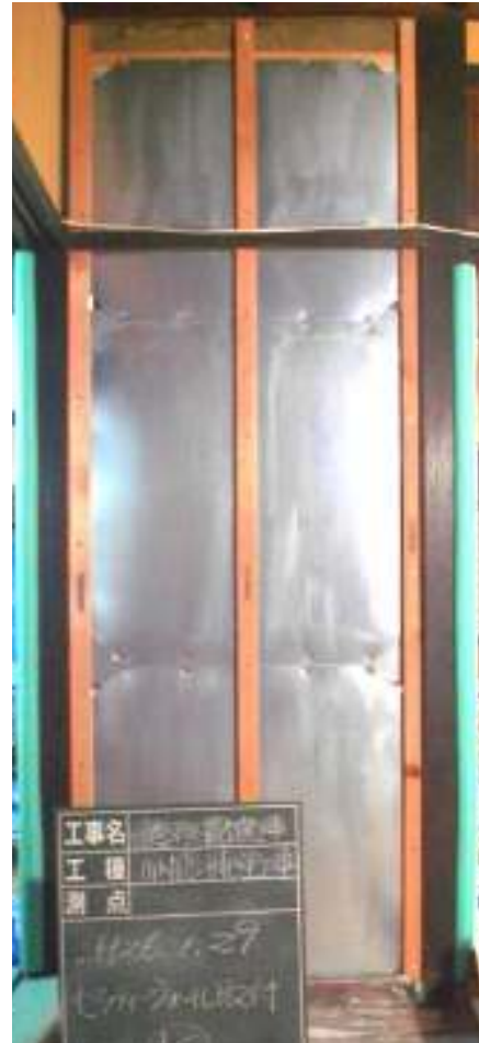
↑複合鋼板の設置状況
