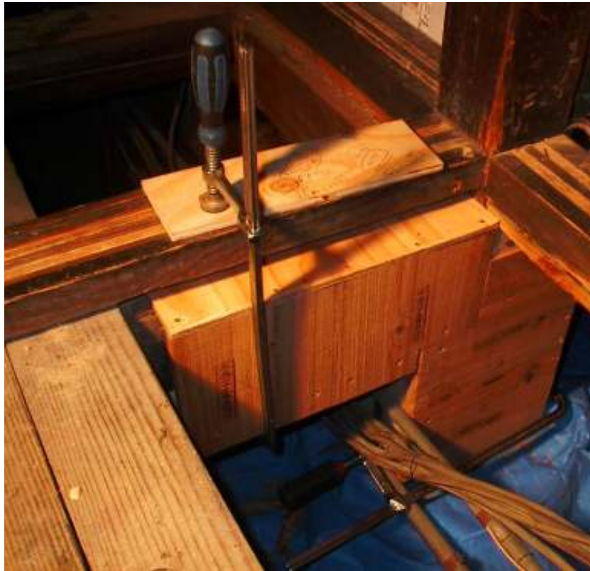
↑既存の柱、大引に新しく木の板を巻いた状態
