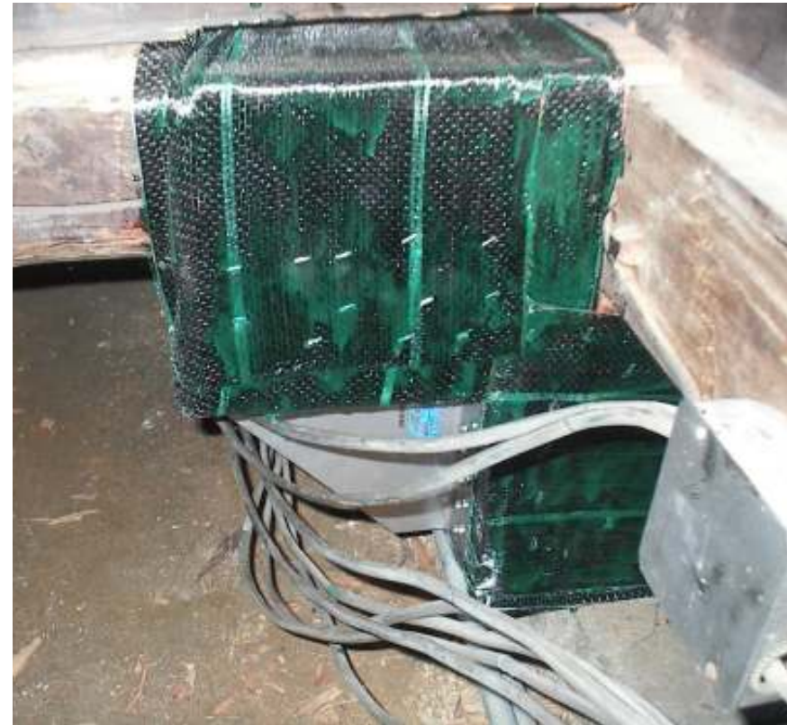
↑炭素繊維を巻き、仕口ダンパーを取り付けた状態
