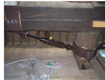
小屋裏の柱-梁接合部
