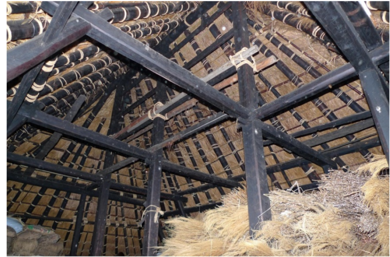
小屋裏から見た屋根
