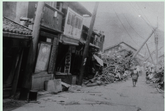
昭和18年鳥取地震による被害。鳥取市川端一丁目付近。
