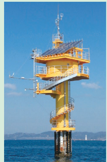
田辺中島高潮観測塔
