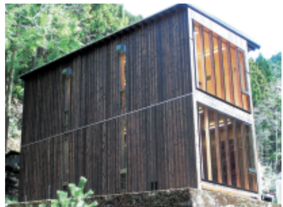
和歌山研究林 j.Pod 教育研究棟全景
