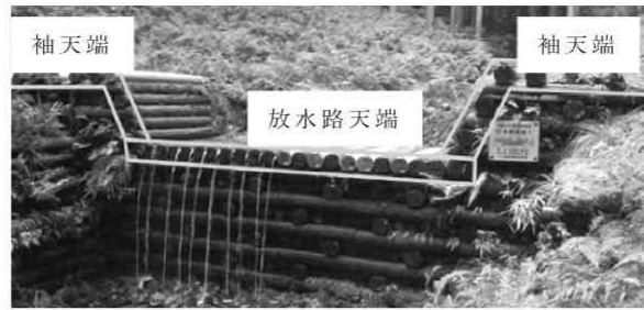
写真 7 : 木製治山ダム
