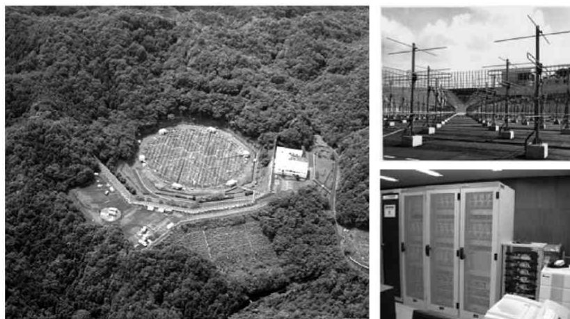
図 1：信楽 MU 観測所全景（左）と MU レーダーアンテナアレイ（右上）、MU レーダー観測強化システムで導入された超多チャンネルデジタル受信機（右下）。
