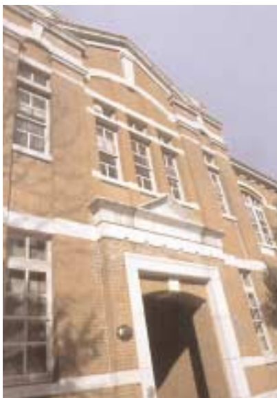
土木工学教室がある工学部5号館
