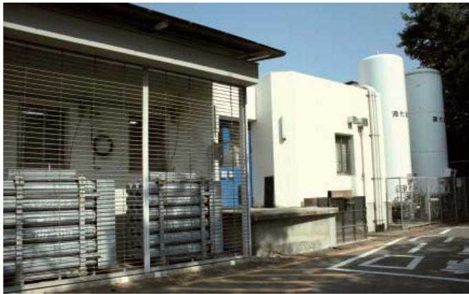
↑奥は液体窒素貯槽。タンクローリーで1万リットル貯槽に搬入され、利用者がくみだす。左手前の建物でヘリウムガスは液化機で液化し、100リットルほどの小型容器に移し、利用者に供給される。2008年度の吉田キャンパスの液体窒素供給量は約20万リットル、液体ヘリウムは約17.5万リットルだった。宇治キャンパス、桂キャンパスでもそれぞれ寒剤供給が行なわれている。
