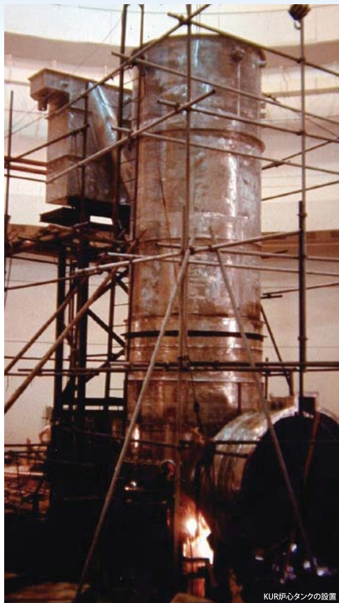
KUR炉心タンクの設置
