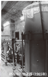
建設中の加速器 (1965年)
