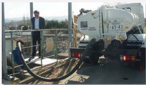
放射性廃水を収集するタンクローリーの作業にて
