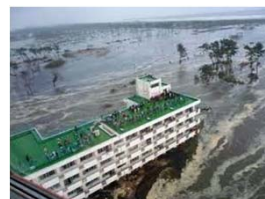
津波襲来中の荒浜小学校 校舎屋上に避難者が見える
