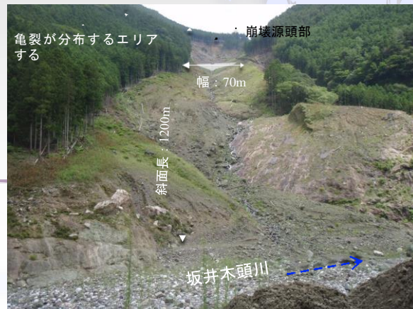
徳島県那賀町阿津江崩壊地の全景
