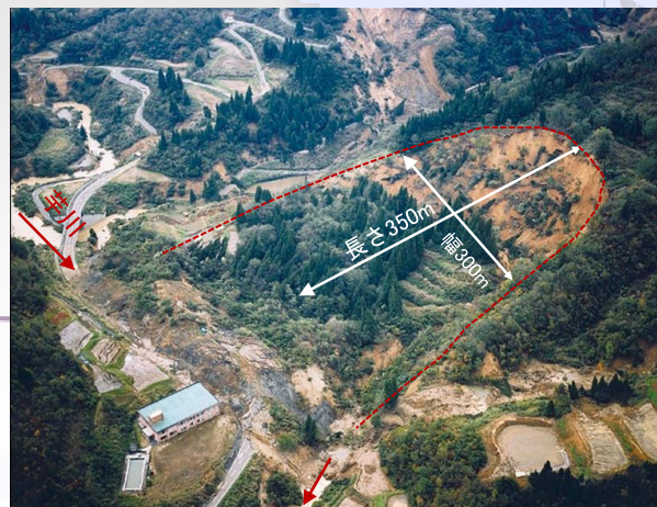
芋川を塞ぎ止めた東竹沢地すべり (2004年10月25日、関東地方整備局撮影に加筆)
