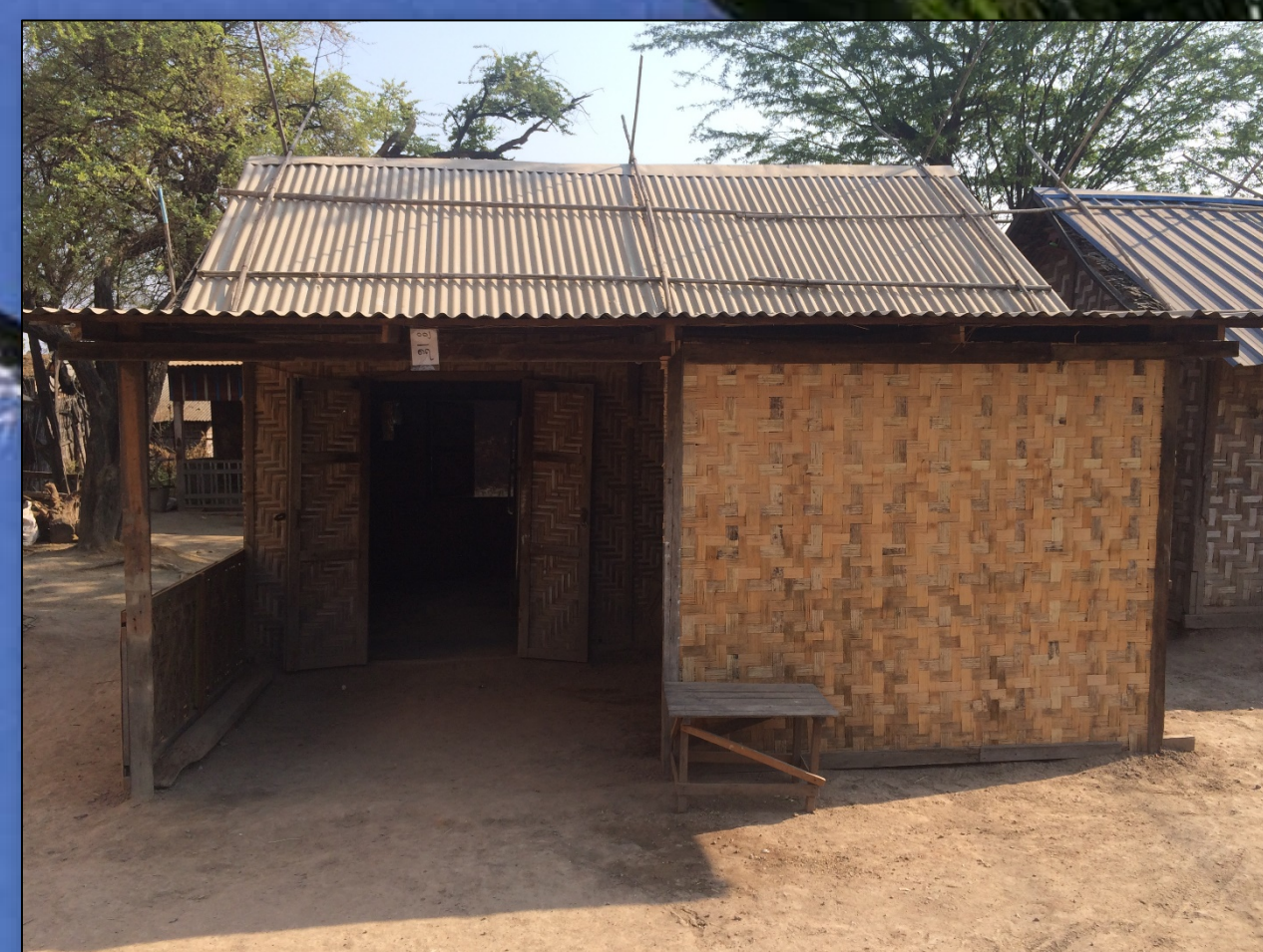
ミャンマー (屋根：トタン板、壁：竹)
