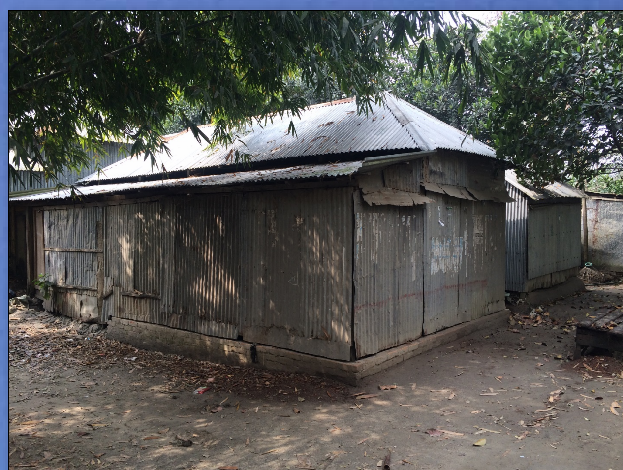
バングラデシュ (屋根・壁：トタン板)
