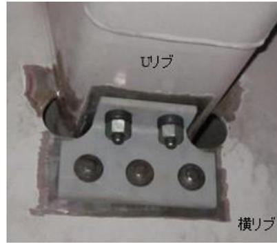
(a) スリット形状の改良・付加板の取り付け (b) Uリブ下面と横リブへの当て板接合
