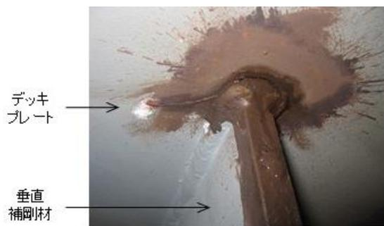
図-1.19 床版内部への泥の流出
