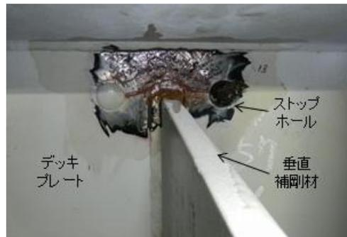
図-1.18 タイプIIのき裂のストップホールによる補修
