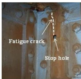
図-4.1 ストップホールによる疲労き裂の応急処置
