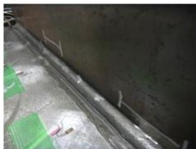
図-2.24 ピーニング処理後の止端近傍の様子
