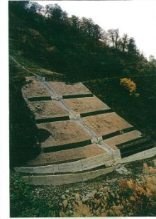
山腹工の施工（ホー15崩壊地）
