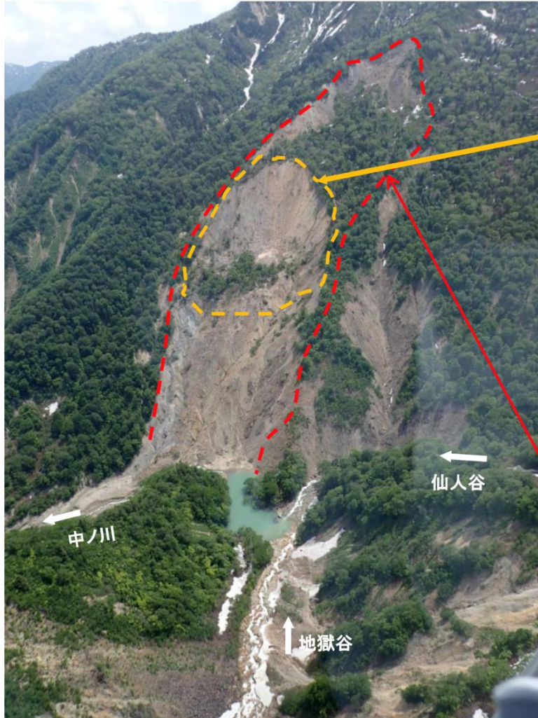
崩壊地正面の状況
