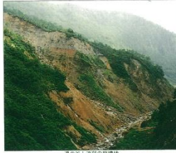
湯の谷上流部の崩壊地
