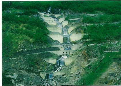
同左堂室谷（A谷）の合止工完成後の状況
