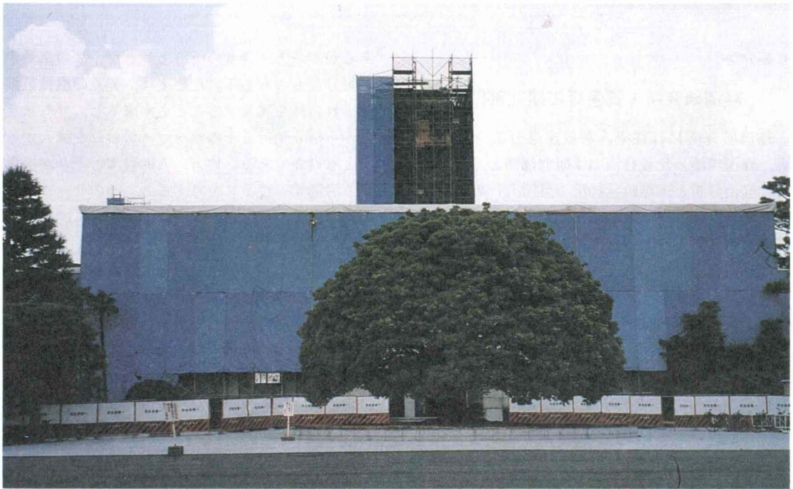
改修中の大学本館
