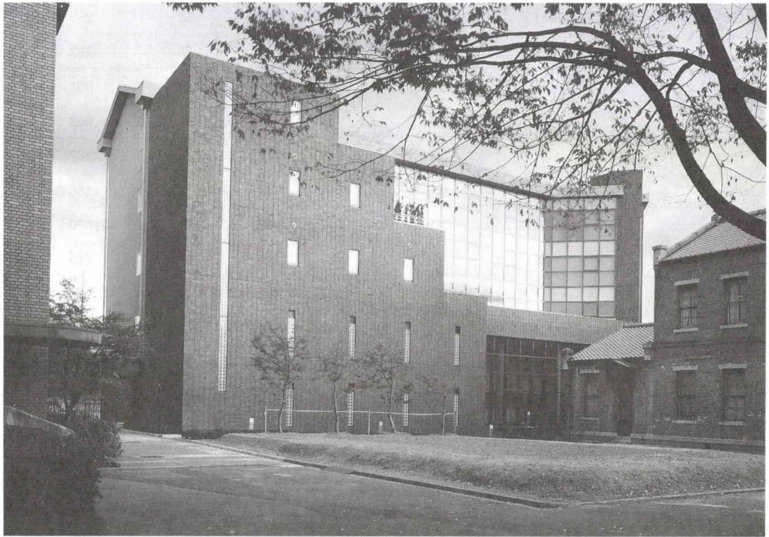
東南アジア研究センター・アフリカ地域研究センター 共同研究棟
