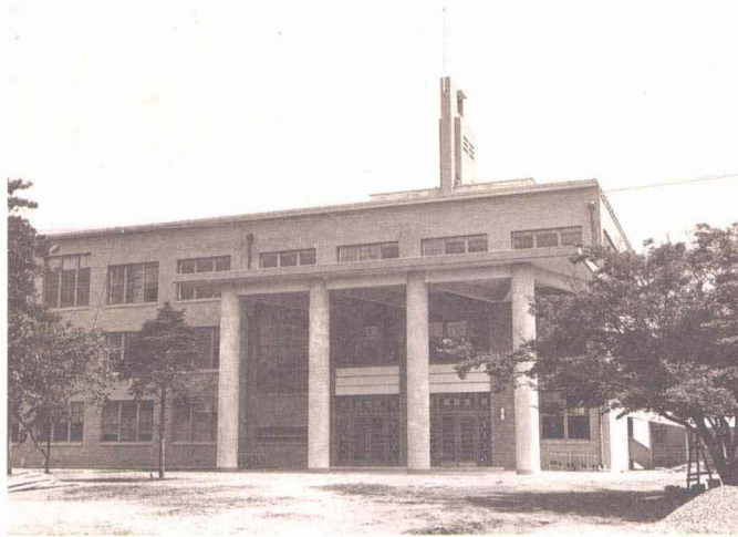
昭和11年に竣工した旧第三高等学校本館
