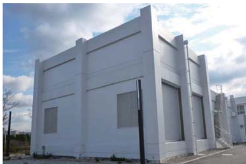
写真4：建て替えられた変電所
