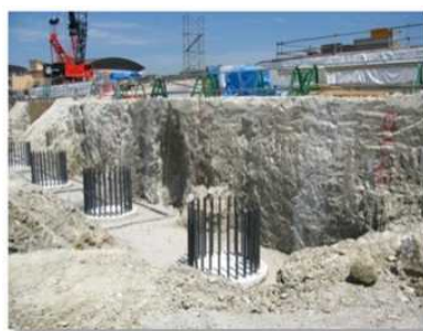
図 3-1 浅層改良土自立山留め工法施工状況
