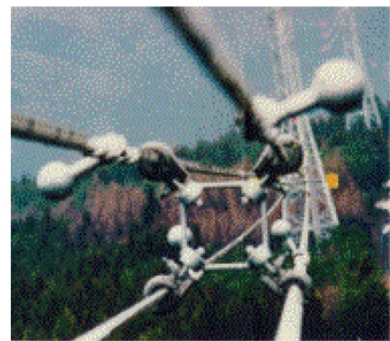
図 1.2.5 Detuning Pendulum [1-7] 図 1.2.6 捻回抑制装置 [1-5] 図 1.2.7 偏心重量錘 [1-67]
