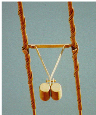
図 1.2.5 Detuning Pendulum [1-7] 図 1.2.6 捻回抑制装置 [1-5] 図 1.2.7 偏心重量錘 [1-67]
