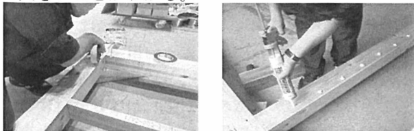
図3 制振素材の施工
