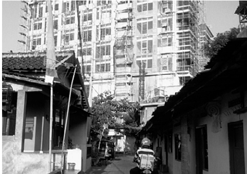
写真2 チョデ川付近に建設中のホテル
