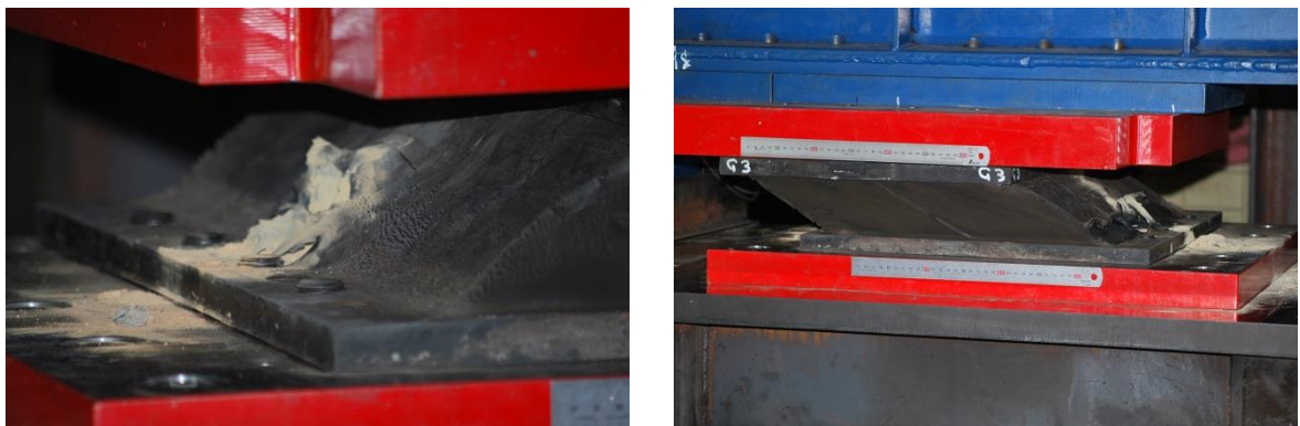
写真-2.3.4 劣化支承側面状況(セット2 載荷時)
