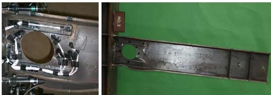
写真 4.1 変形状況 (No.3z 試験体)
