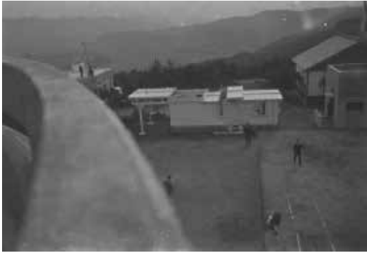
46.敷地風景（大ドームより）
