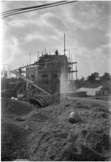
29.花山天文台建設現場
