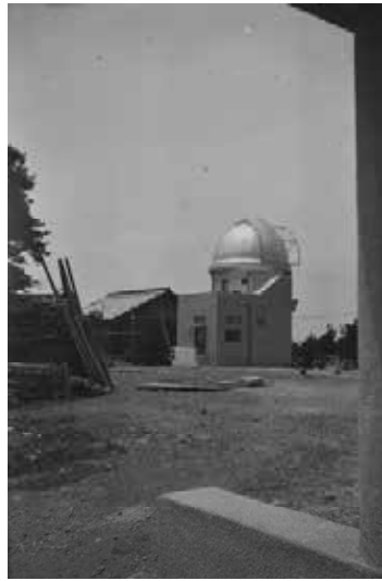
34.小ドーム完成
