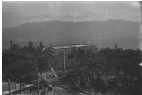
27.花山天文台建設現場
