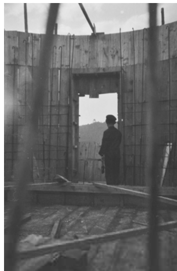
21.花山天文台建設現場
