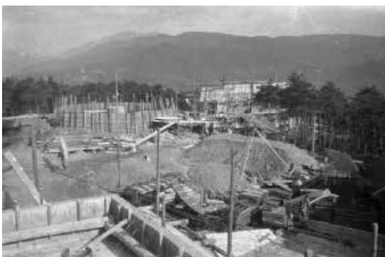
28.花山天文台建設現場
