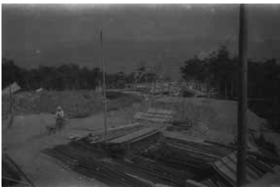
18.花山天文台建設現場
