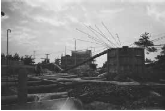
15.花山天文台建設現場
