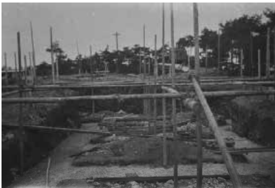
21.花山天文台建設現場
