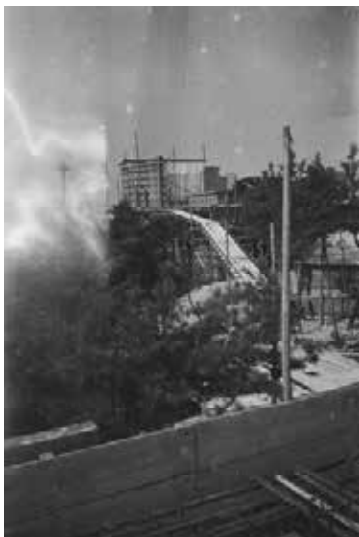
20.花山天文台建設現場
