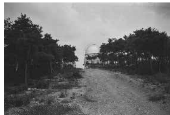
30.大ドーム完成
