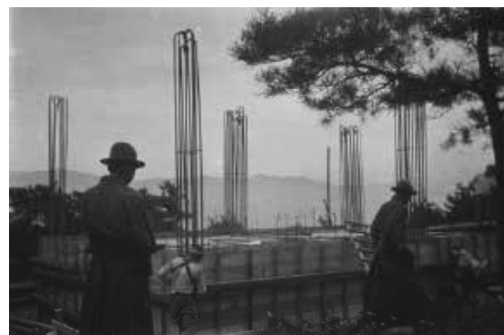
21.花山天文台建設現場
