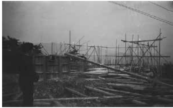
17.花山天文台建設現場
