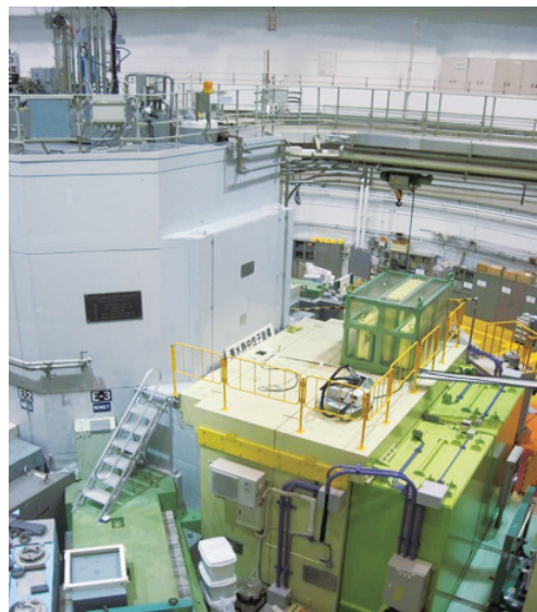
◀ 京都大学研究用原子炉（KUR）とBNCTのためのエネルギーの低い中性子を取り出す重水照射設備。世界的に極めて優れた、数少ないBNCT臨床治療施設である。 Kyoto University Research Reactor (KUR) and Heavy Water Irradiation facility. This facility can emit low energy neutron beam suitable for BNCT, and unique and excellent BNCT facility for the clinical trials of BNCT.
