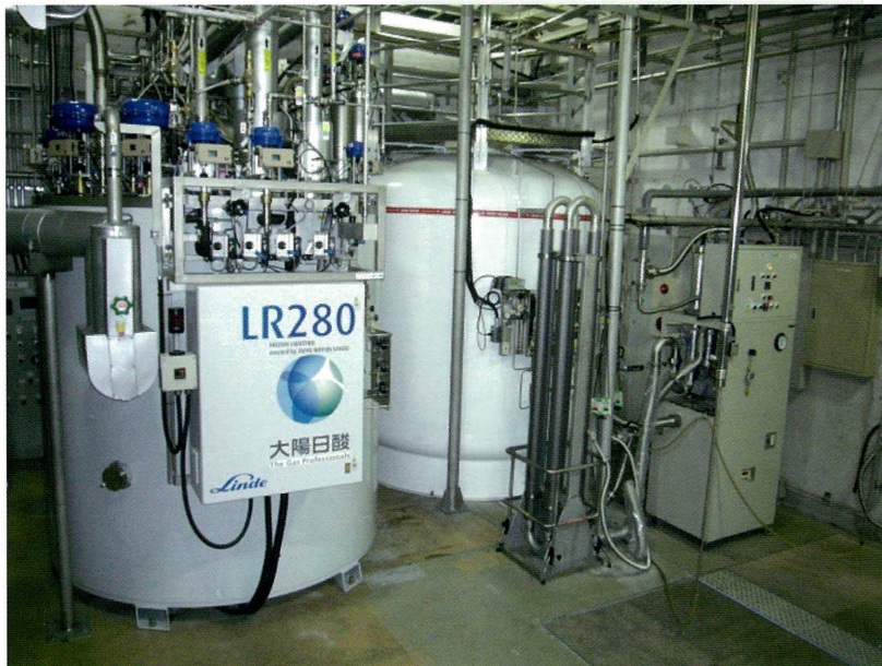
吉田キャンパスの新規ヘリウム液化システム
