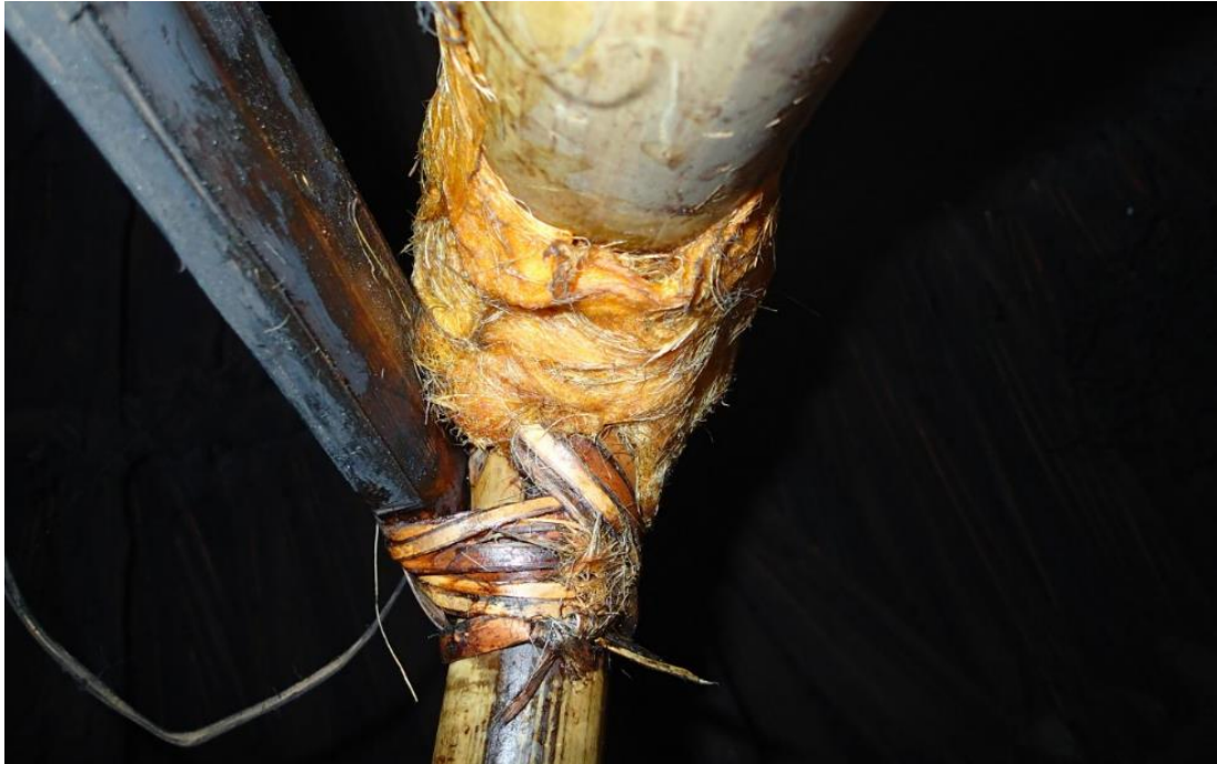
写真 6 葉を細く割いた紐で結ばれた家の柱 14
