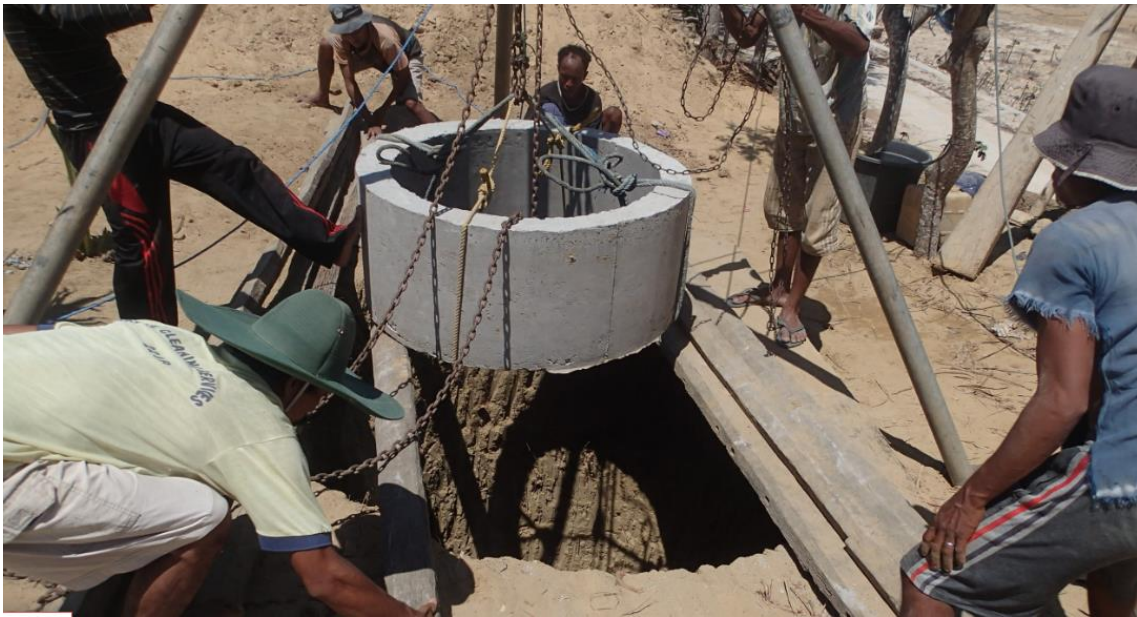
写真 23 土を掘って井戸となるセメントを下ろす作業 42
