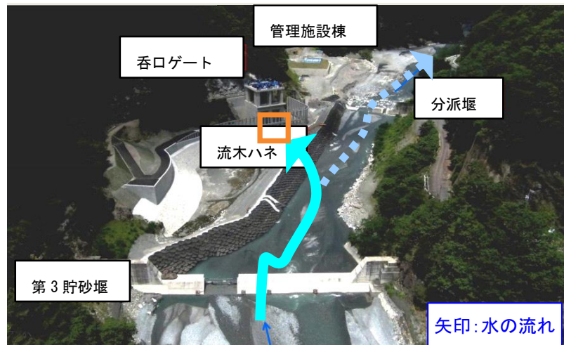
図 4-16 小渋ダムの土砂バイパス施設 (出典：天竜川ダム統合管理事務所)
