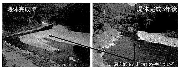
写真1 貯水ダム下流域における河川環境変化の例
