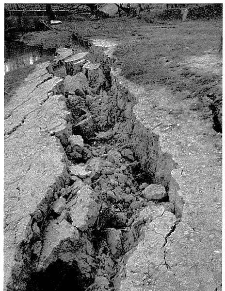
写真2 Sinizzo湖岸にできた地面のひび割れ
