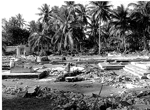
写真2 マルサワの深刻な津波被害 ほとんどの建物は基礎しか残っていない
