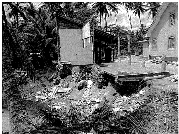
津波によって洗掘された地盤と破壊された建物 (スリランカ南東部)
