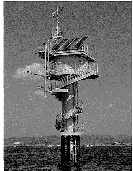
白浜海象観測所 高潮観測塔
