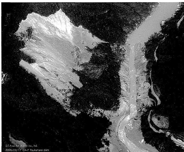
宮崎県耳川流域で発生した最大規模の崩壊 (野々尾，アジア航測撮影)
