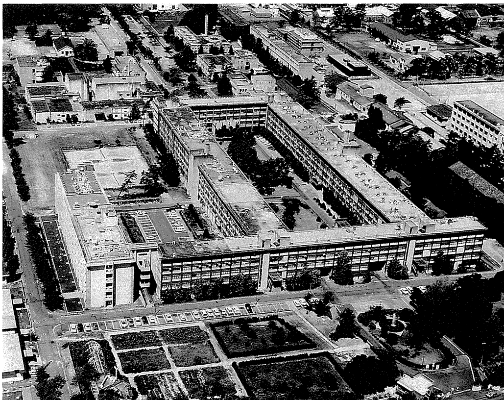
宇治構内総合研究棟（1970年竣工）
