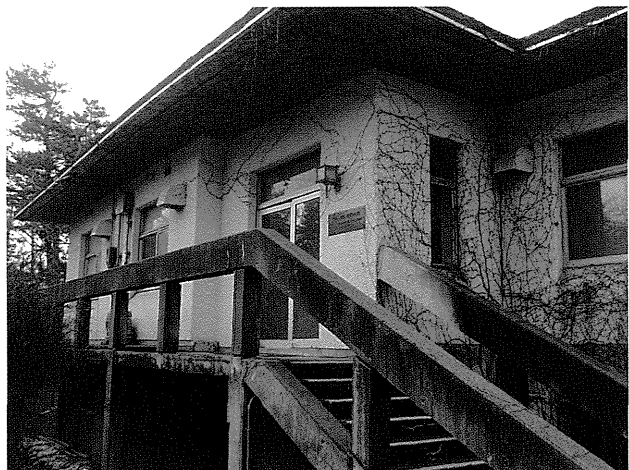
大潟波浪観測所本館
