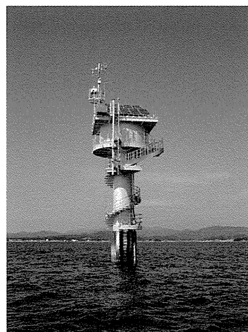
白浜高潮観測塔
